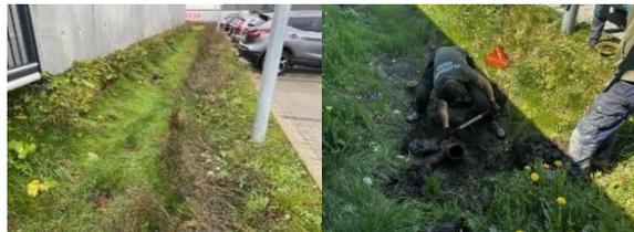
Pozo de desagüe, elevado a un nivel de 5 cm por debajo del punto más bajo del lecho pluvial. Se construye una "estructura" de cantos rodados alrededor del pozo. Posiblemente se construya en un muro a través del jardín de lluvia.
